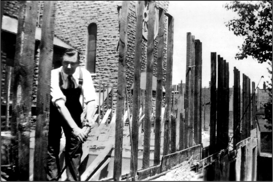
Nikolaus Plechl *1899 beim Bau der Halle.
