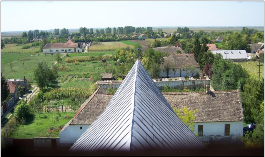
Richtung Südwesten, im Hintergrund Spital, ungarischer Friedhof, Kanal.
