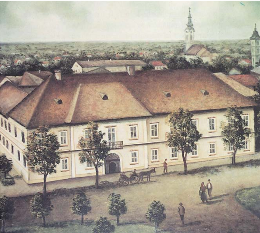
Das Gebäude der Kameraladministration in Sombor
